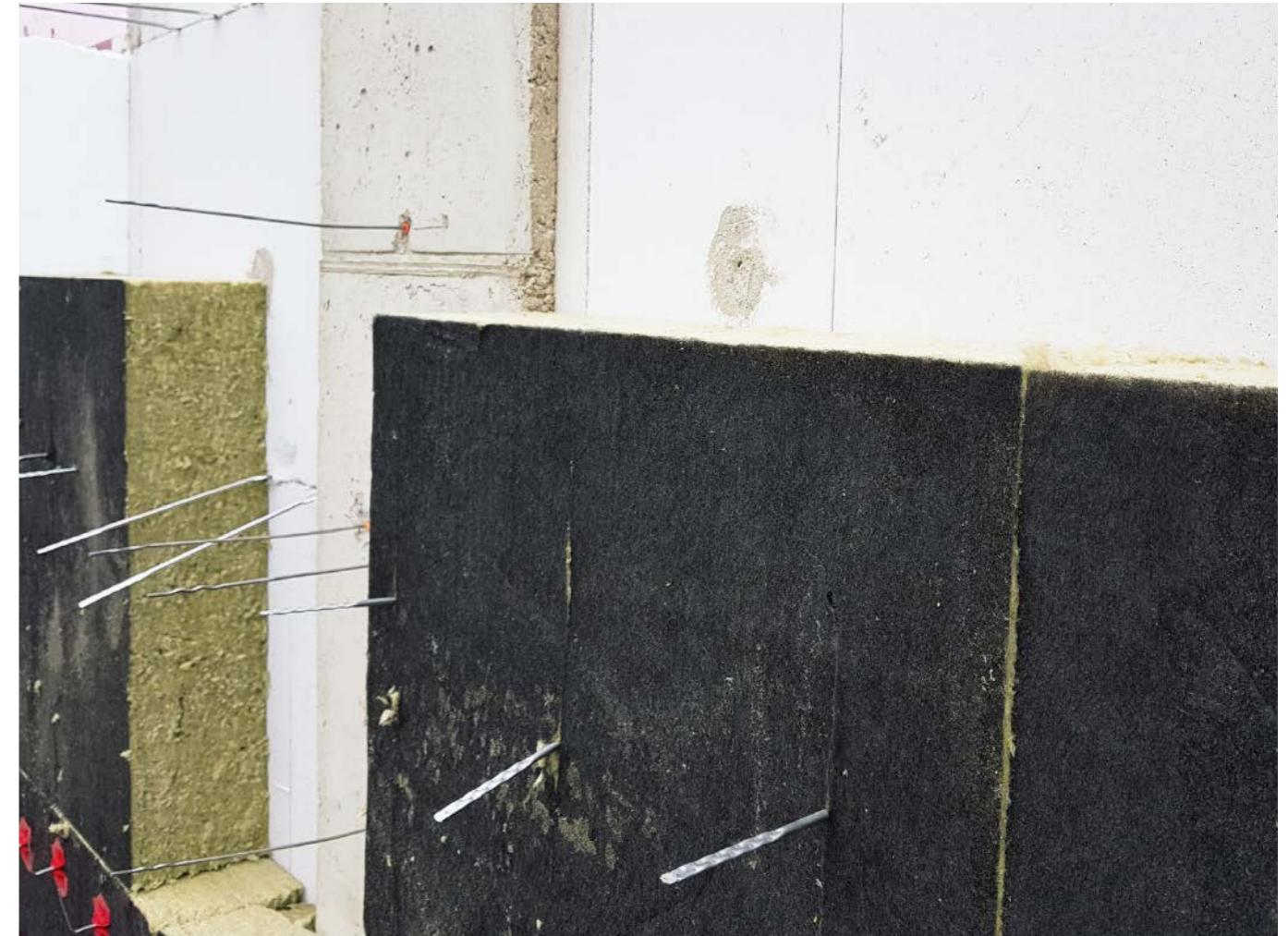
Die vlieskaschierten Kerndämmplatten verfügen über die gleichen Vorteile wie die unkaschierten Produkte. Sie lassen sich ebenfalls leicht auf die vormontierten Mauerwerksanker aufbringen und ermöglichen eine schnelle und problemlose Verlegung.
