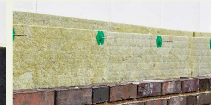
Die Dämmstoffplatten werden im Verband verlegt und so auf die Mauerwerksanker aufgebracht, dass sie dicht gestoßen ohne Fuge an der Wand und an der nächsten Platte anliegen. Durch die Struktur der Steinwolle-Dämmplatten verfilzen die Plattenstöße miteinander, sodass eine dichte und gleichmäßige Verlegung entsteht.
